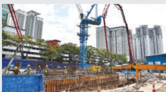
Kawasan binaan Construction area
